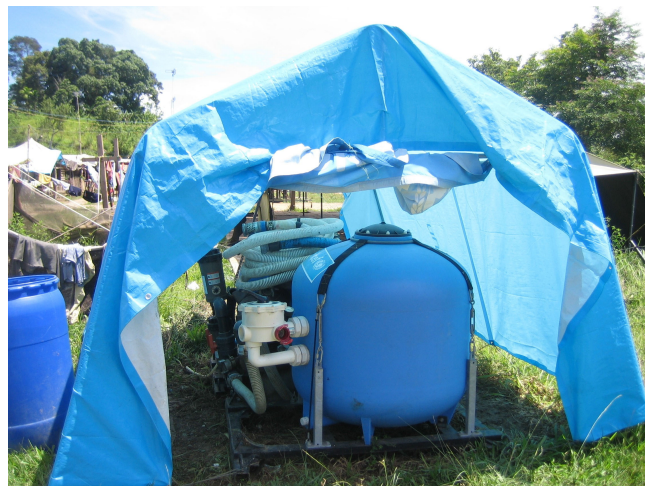
Oczyszczalnia ścieków w Aceh w Indonezji (Źródło: ETO)
